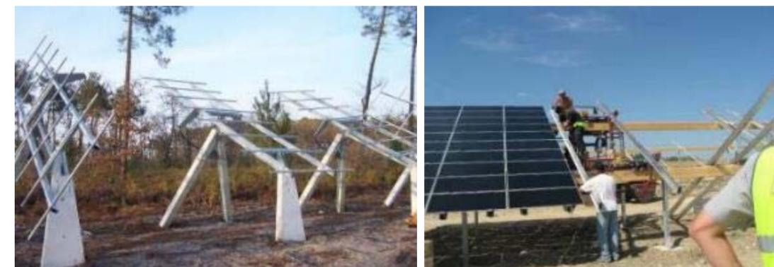
Figure 23 : Montage des supports de la technologie « trackers » (à gauche), montage de modules sur des supports fixes (à droite)
