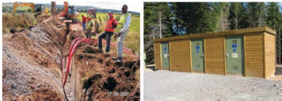
Figure 24 : Déroutage et pose des câbles (à gauche), exemple de poste de livraison (à droite)
