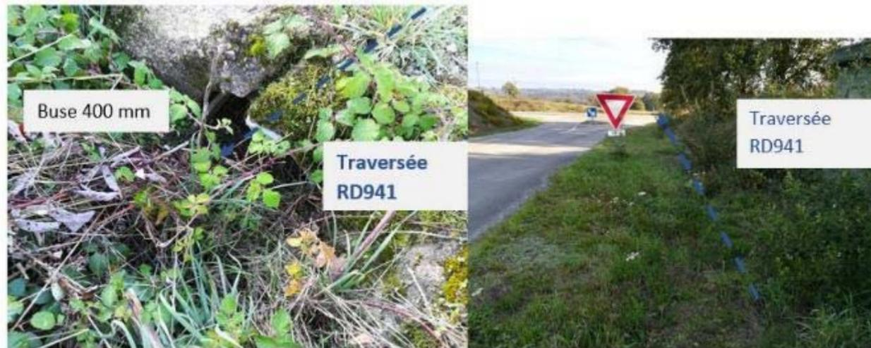
Figure 55 : Photographie canalisation 400 mm traversée (source : ARTELIA)
