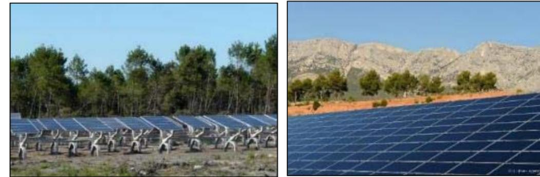
Figure 10 : Structures solaires (à gauche: les trackers de la centrale de Gabardan (40) qui suivent le soleil ; à droite : structures fixes à Puylobier (13)) - Source : EDF Renouvelables
